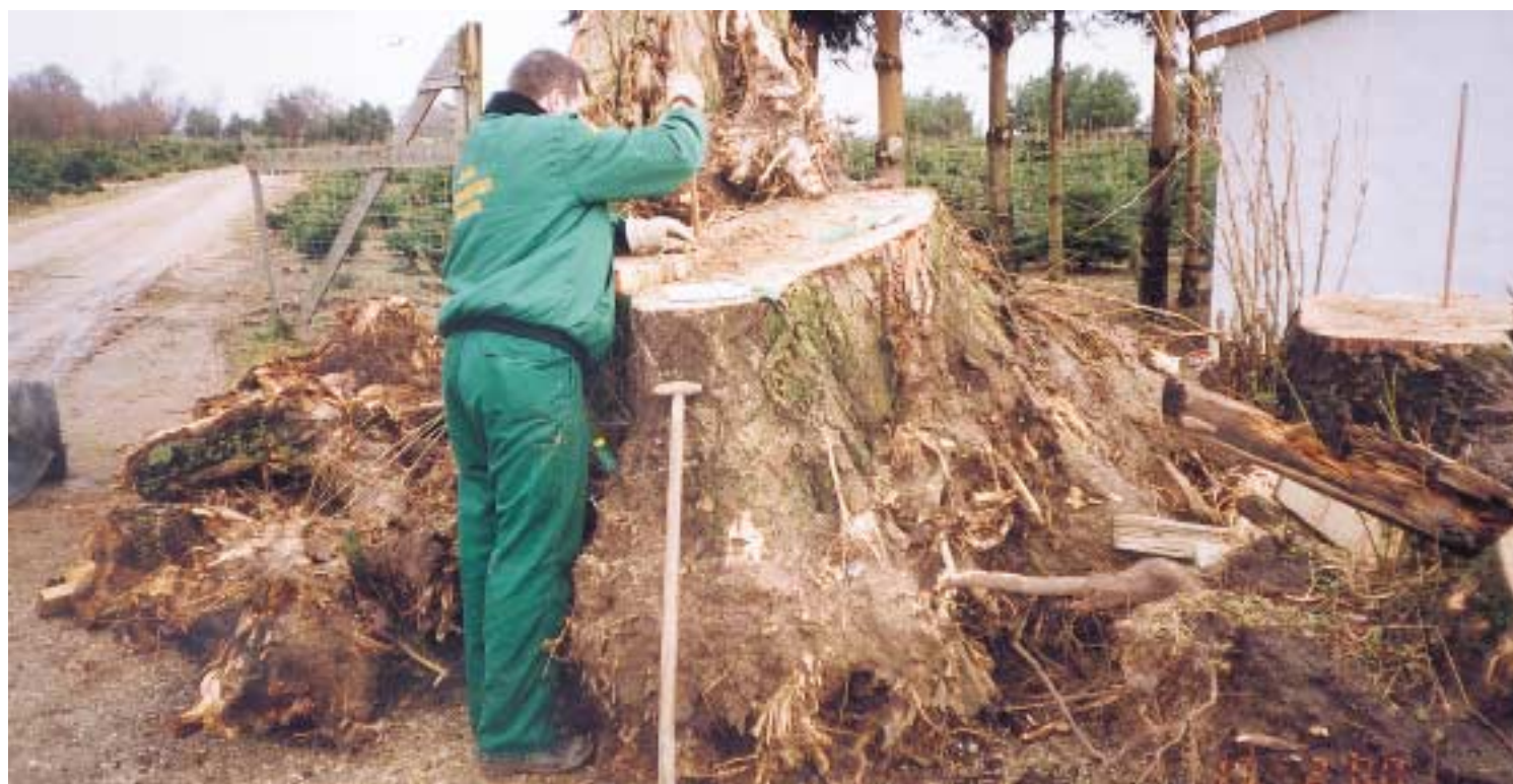
Trærød (ø 0,9 m i brysthøjde) er først sprængt op med 8 ladninger á 400 g Dynamit og derefter er roden flækket med 3 ladninger á 100 g for at kunne blive lastet på lastbil og kørt bort. I alt 10 rødder blev fjernet nær hus.
