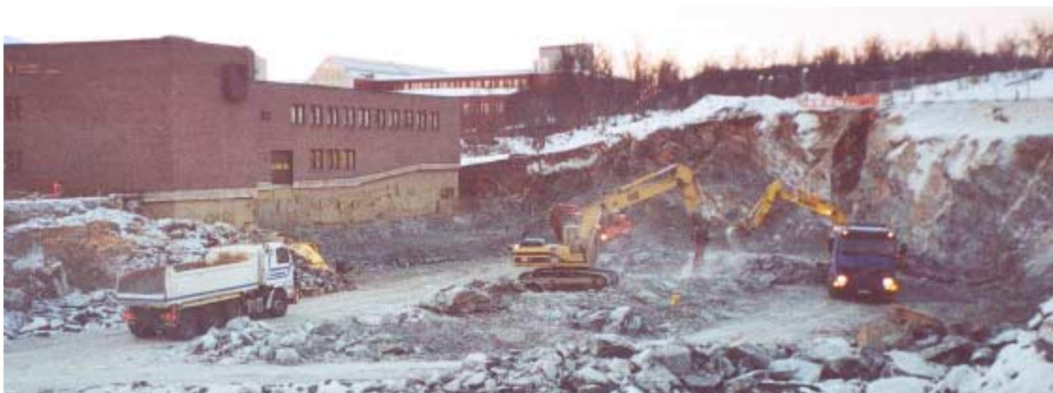
Sprengningsarbeid med strenge krav til rystelser
