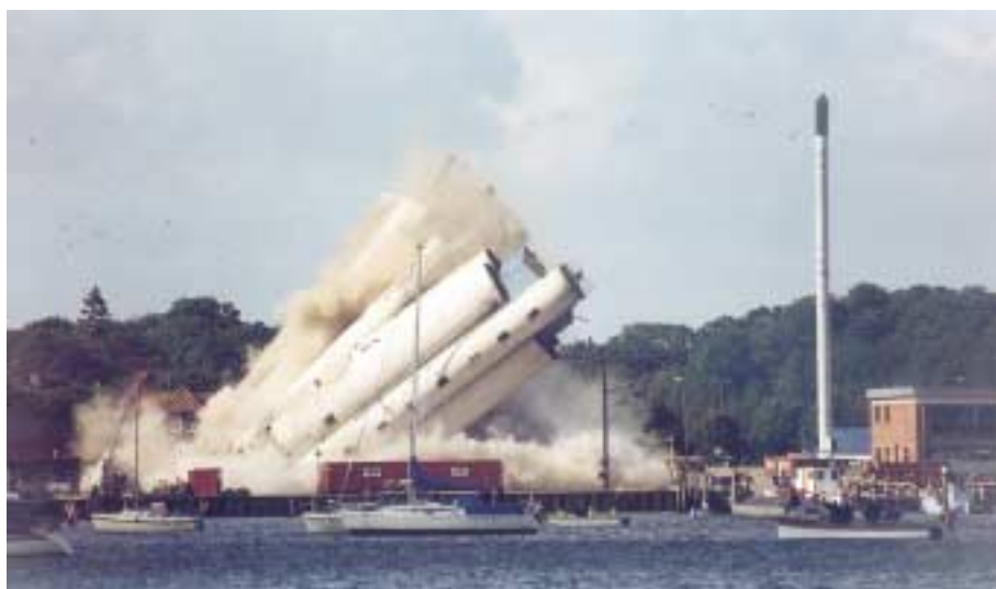
45 m langt, 12 m bredt og ca. 35-40 m højt siloanlæg væltes i Gråsten maj måned 2001. Der er boret ca. 430 huller, der er anvendt ca. 5 kg Dynamit og ca. 120 m sprængsnor (detonerende lunte) 40 g/m.
