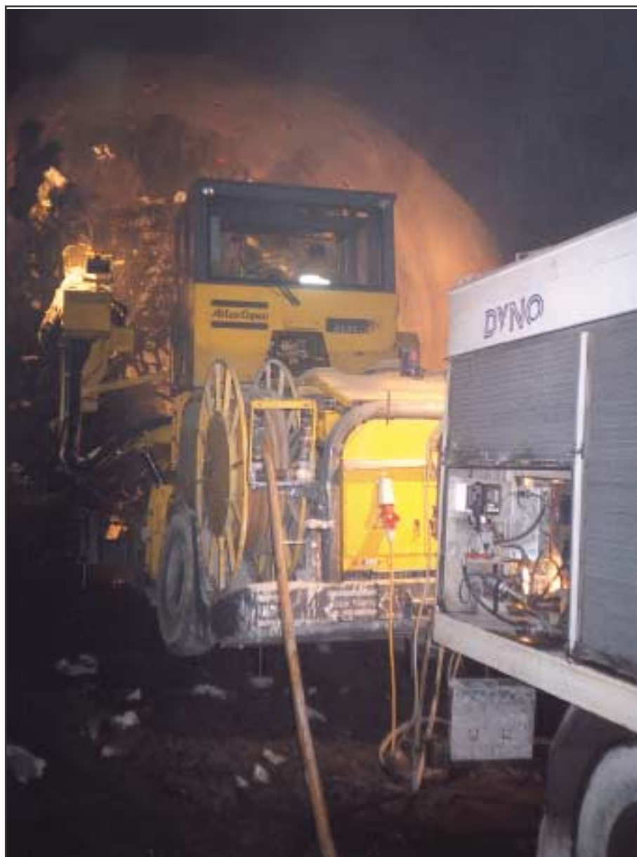
SSE-testlading med østerrikske drivere på stoff vest imot sør. Ladetruck 10 II under produksjon og lading.
