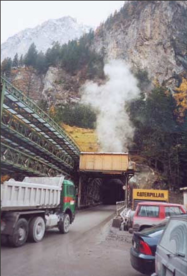
Tverrslaget i Mitholz (Fensterstollen). Knust tunnelmasse blir transportert ut på rullebånd.
