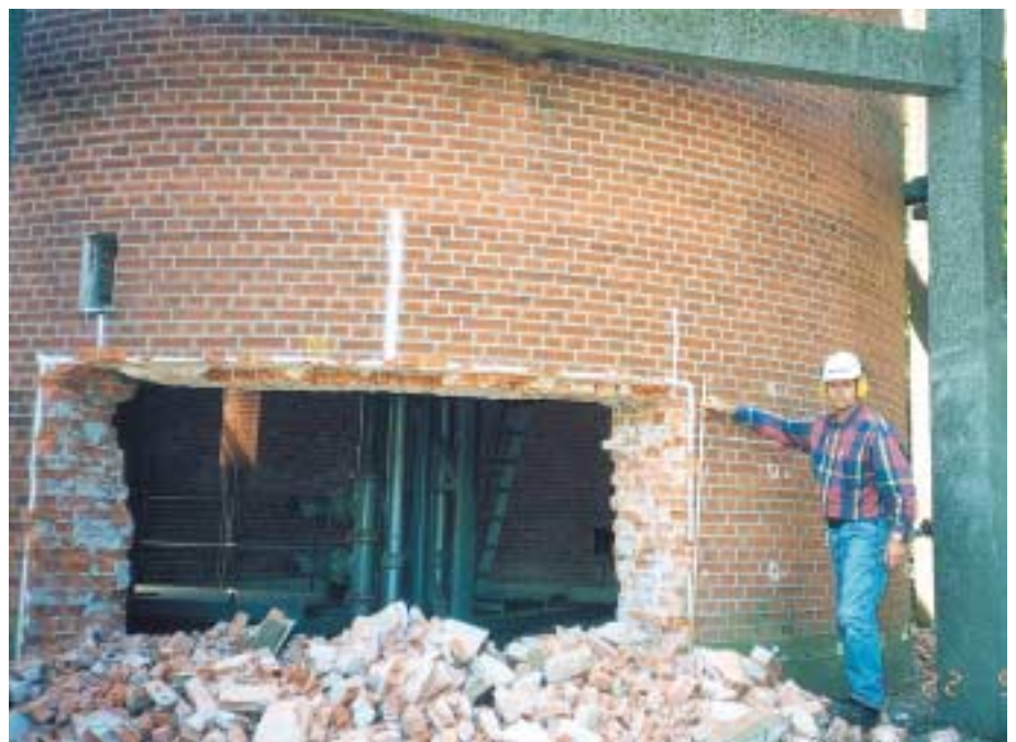
Morten de Thurah foran udhugning af faldslids i et 40 m højt vandtårn i Århus
