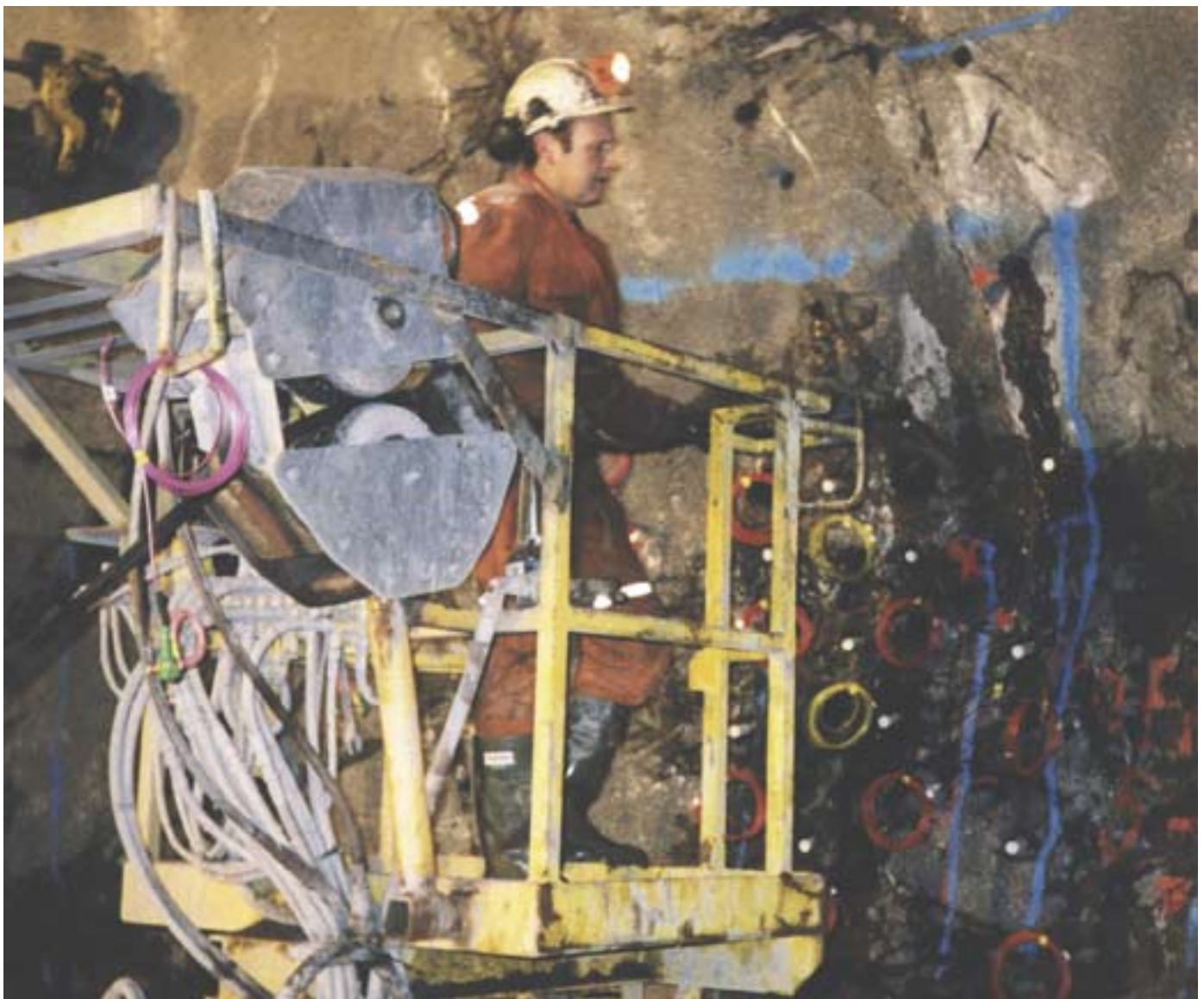
Fig.12. Strengladning av F-kutten med uttreksmekanismen. Bunnladning + 0,9 kg/m.
