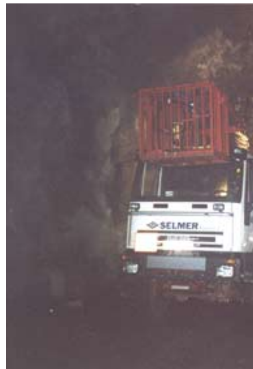
Fig.11. Mini-SSE ladetruck på stoff i Chalmers-tunnelen. Uttreksmekanismer for strengladning fra lademengder før oppstart
