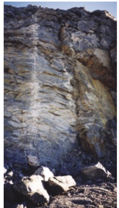
3. Borehull med synlig borepiper der detonasjonen har gått fra bunnen og opp, og fra topp og ned. Vi ser også deler av borehullet der det ikke har vært detonasjon.
