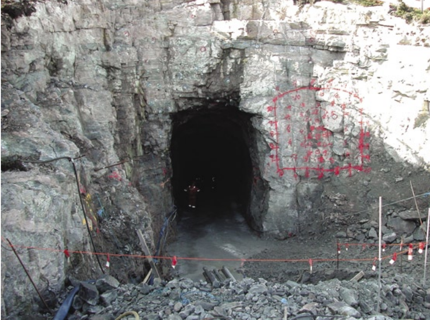
Alt klart til salve. Boreplan i full størrelse er tegnet på veggen
