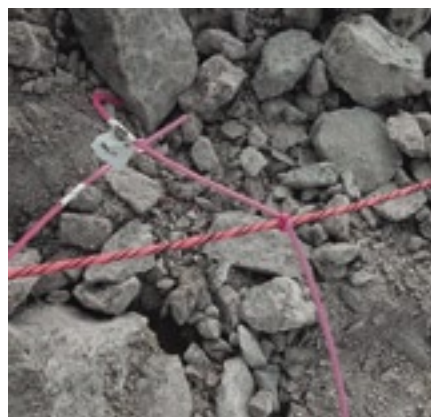
Oppkobling av salve skjer ved at slangene fra borehull knyttes på den detonerende lunta som går langs hullrekker i salvens utslagsretning.
