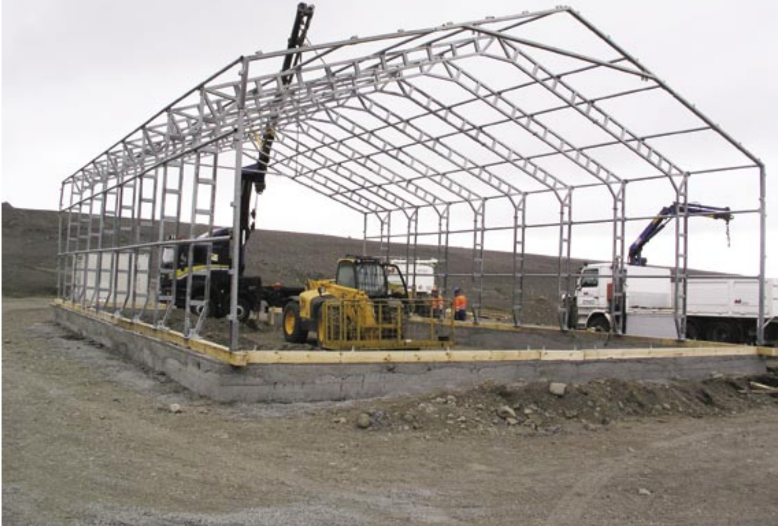
Produksjonshall under bygging på Kárahnjúkar
