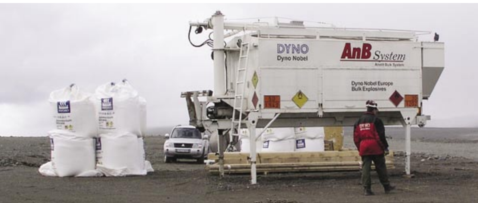
Utstyr og råvarer på veg inn til anleggsområdet
