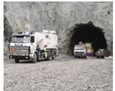
Leveranse til Leonhard Nilsen som driver en ca. 1 km lang veggstasjon ved Höfn
