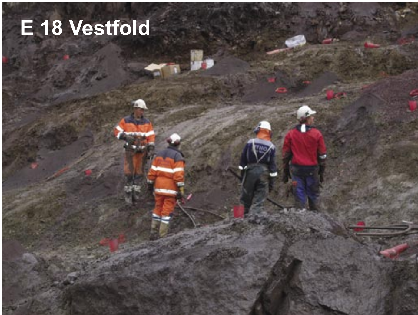
Lading for dagsprengning på E - 18
