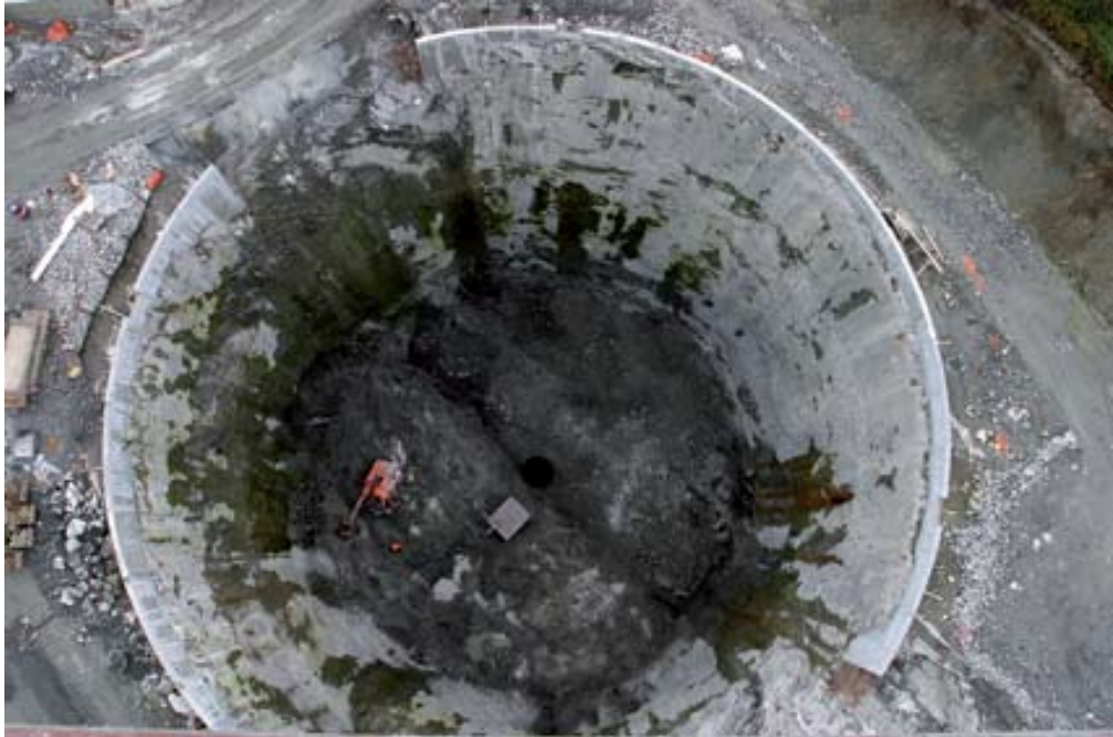
Mennesker og maskiner blir små i malmsiloen. Denne er drevet halvveis, eller 30 meter ned. Midt i bildet sees hullet til sjakten som brukes til å dumpe sprenget stein ned til transport-tunnelen
