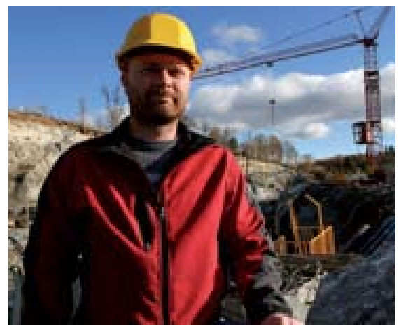
Faglig leder Leif Søbstad i Høgmo Fjellsprenging kan melde om en krevende bore- og sprengjobb i Glomma. Foto: Einar Gjærevold
