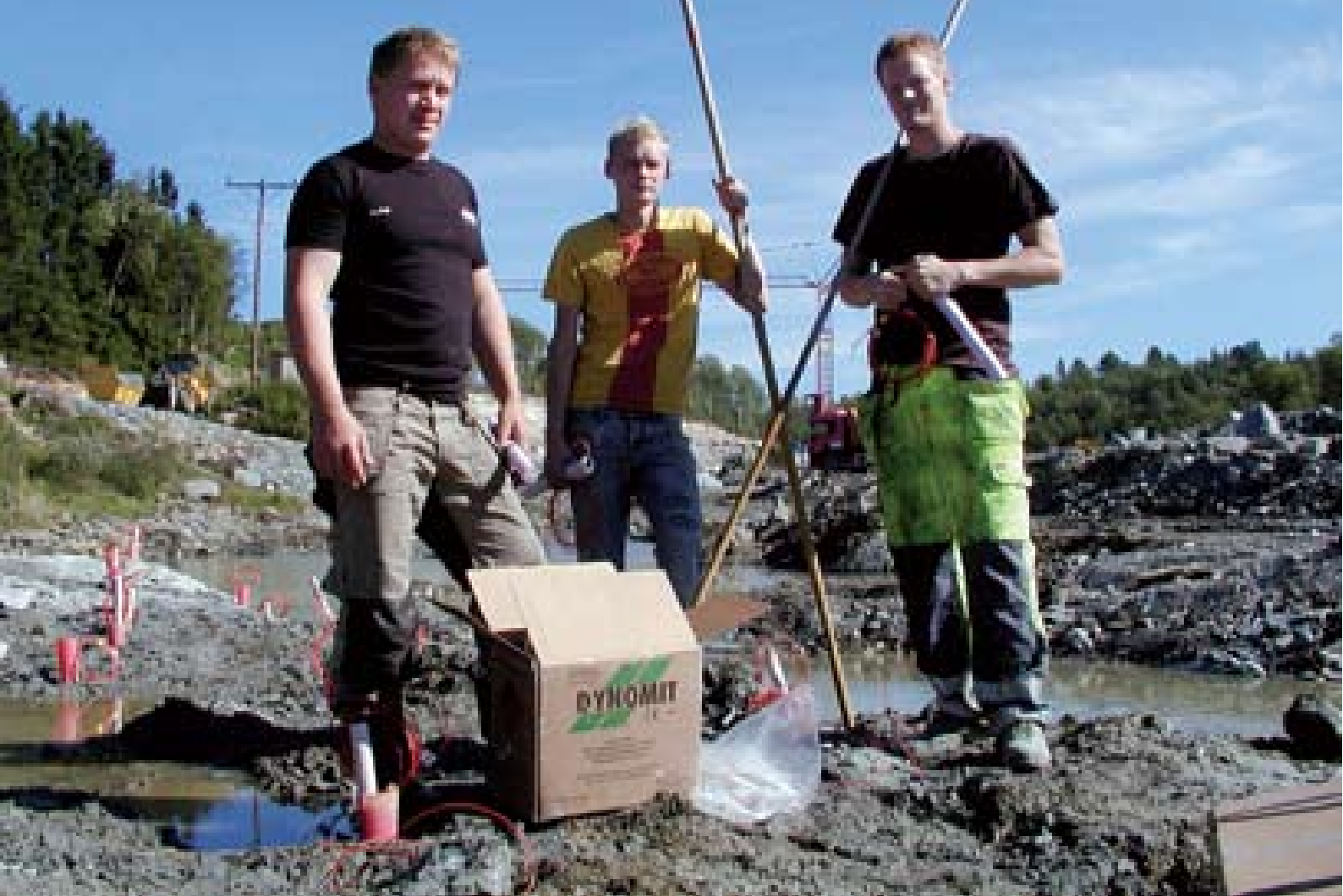
Et team fra Høgmo Fjellsprenging lader og lager overløpskanal. Fra venstre assistent Arild Storhaug, boreriggeroperatør Thomas Angelsen og skytebas Andreas Gran (fra AG Fjellboring). Foto: Ole Jørgen Kjellmark
