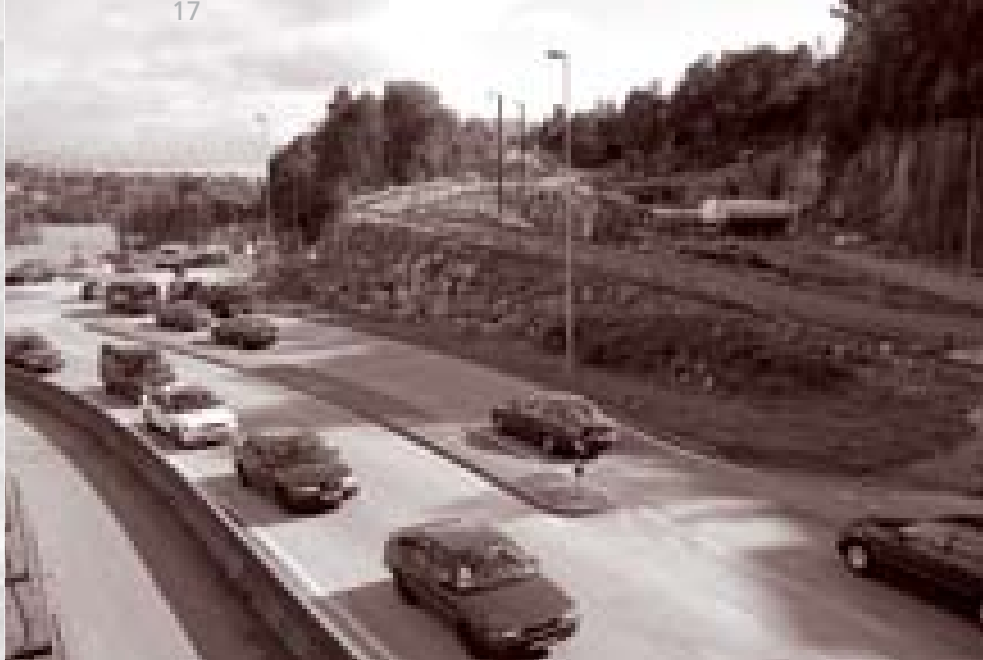
Rushtrafikken på Sandeide setter tålmodigheten på prøve både hos bilister og anleggssjåfører. Her sees det nordøstlige innslaget til Knapphullet
