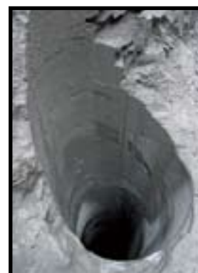
Dumpehull for løsmasser, boret av en raisedrill med skjærkroner.
