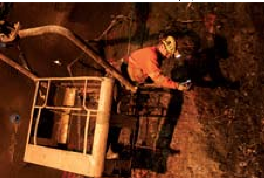
Eivind Stendal fra Veidekke plasserer injeksjonsstavene i stuffen. For at stavene ikke skal gjøre skade, hvis trykket blåser dem ut, er de lenket sammen
