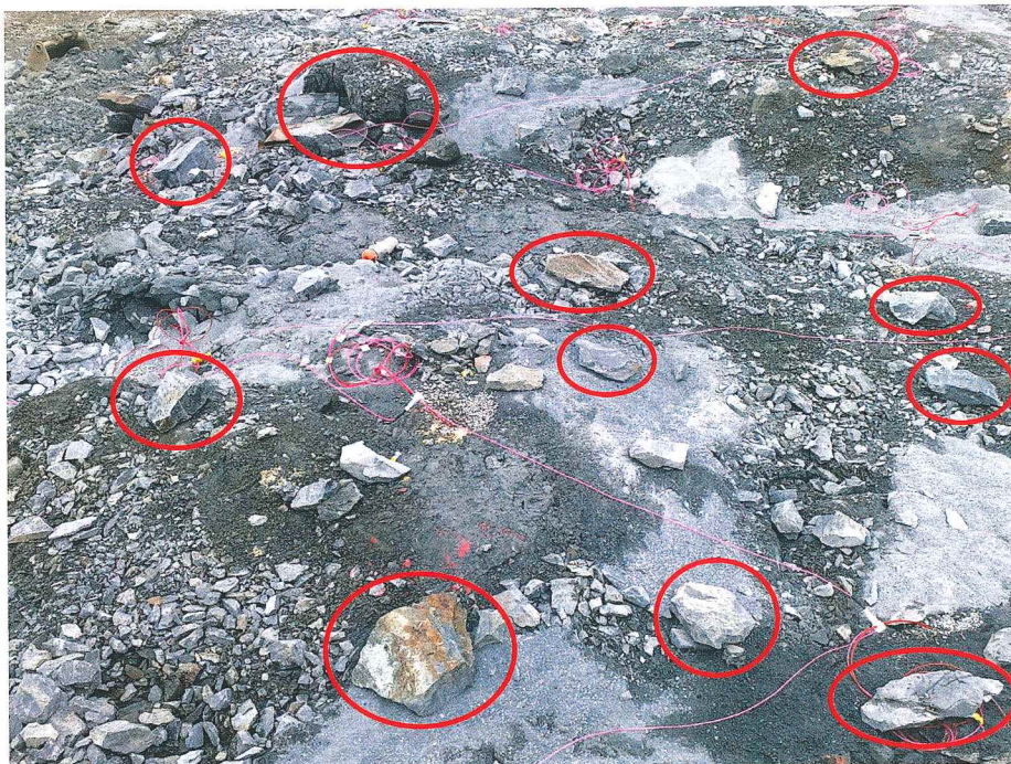
Her ser vi hvordan steiner er plassert for beskyttelse av Exel™-systemet før dekningsmattene legges på.
