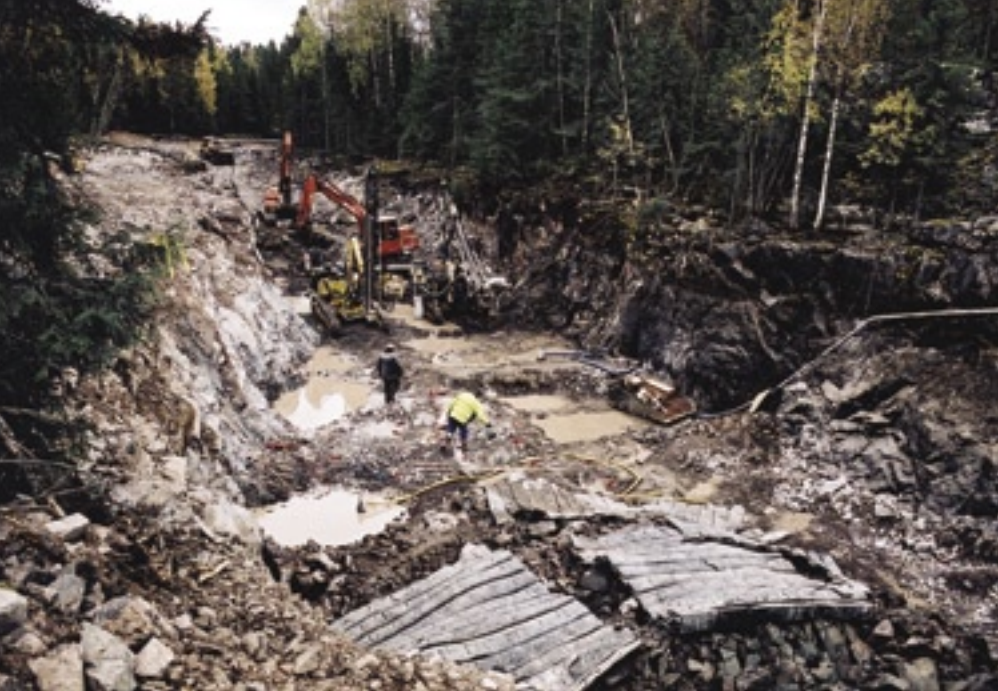
I Johannisholms fors i Vanån bygger Skanska en kanal och en kraftstation.
