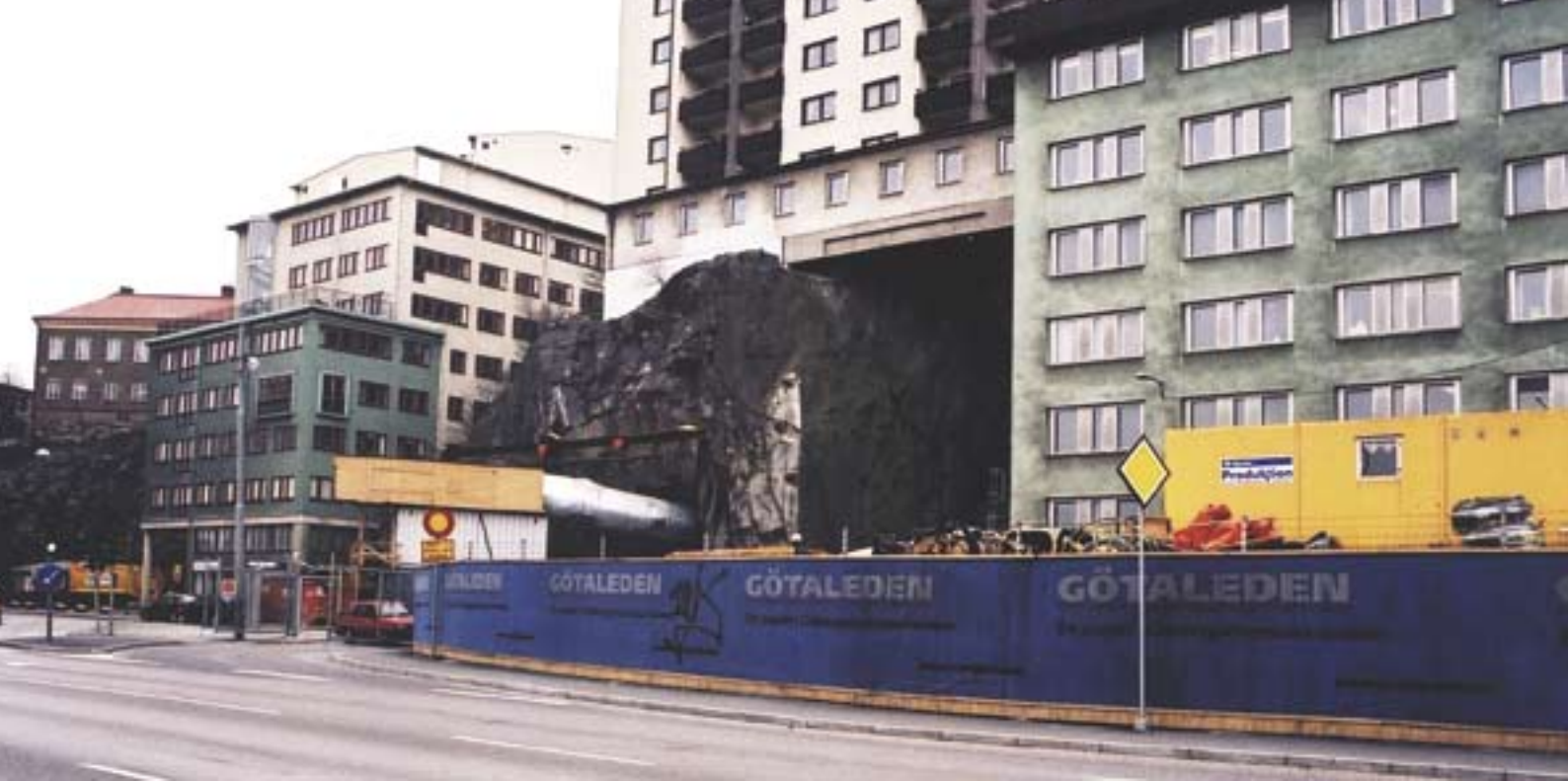
Mitt under Göteborg byggs Götatunneln. Här syns nedfarten från Södra Badhusgatan.
