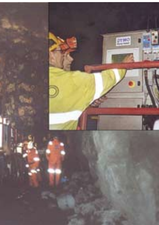
Chalmers-tunnelen. Den er forsynt med 2 uttøkk og fra såle. Innfelt : Innstilling av oppstart av ladingen.
