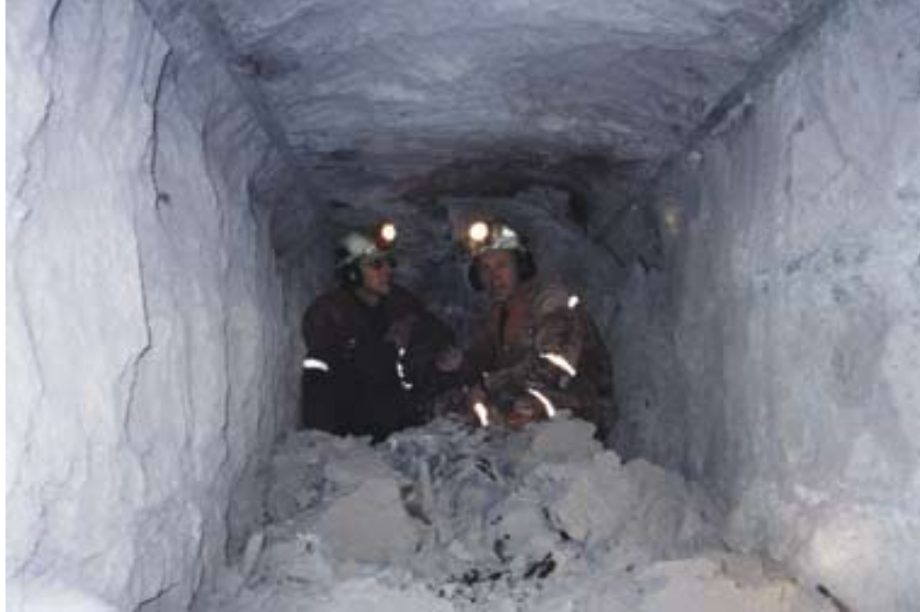
Fig.5. Tunnelbas Kjell Mykstu og kollega på plass i F-kutten umiddelbart etter sprengning. Et meget godt resultat.
