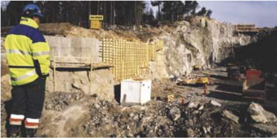
Här byggs Postens nya huvudkontor i Tomtebodavägen
