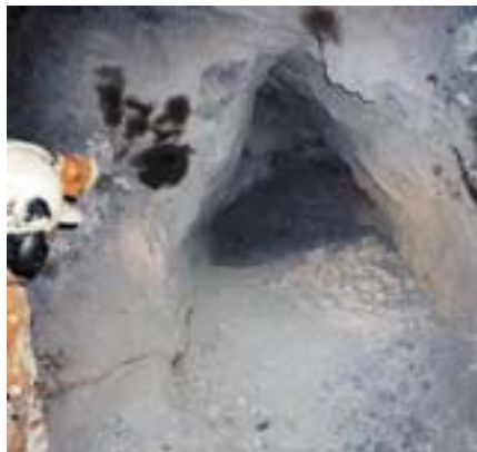
Fig.6. S-kutten etter sprengning. To øvre hjelperhull på hver side av kutten feil-funksjonerer. Ikke fullt så godt resultat.
