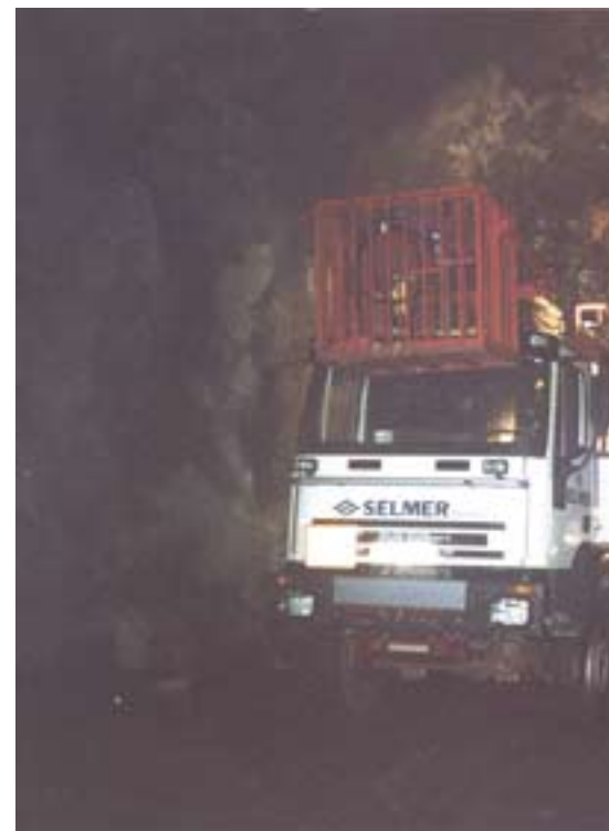
Fig.11. Mini-SSE ladetruck på stuff i Chalmers-tunnelen. Bildet viser reksemekanismer for strengladning fra laster til lademengder før oppstart.
