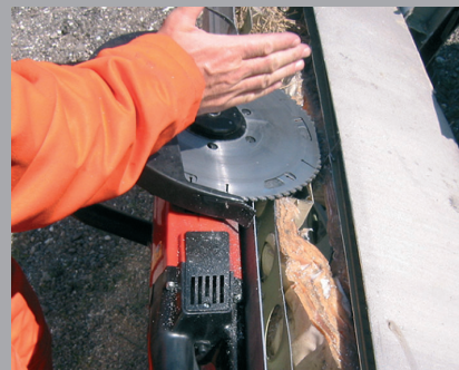
Rene snit i konstruktioner og isolering
